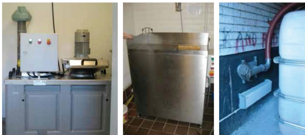
شکل شماره ۱۸: یک دستگاه آسیاب و یک دستگاه متصل به مخزن (سمت چپ). یک راه حل ساده‌تر، با یک آسیاب در آشپزخانه متصل به مخزن که در یک اتاقک پسماند قرار داده شده (سمت راست)
