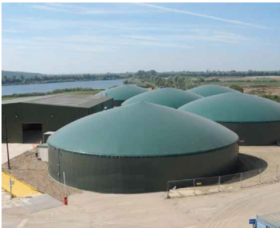
شکل شماره ۷: تأسیسات هضم بی‌هوازی Cassington در آکسفوردشایر، انگلستان. منبع فرآیندهای این کارخانه بیوگاز پسماندهای غذایی شهری و تجاری تفکیک شده در مبدأ می‌باشد.
